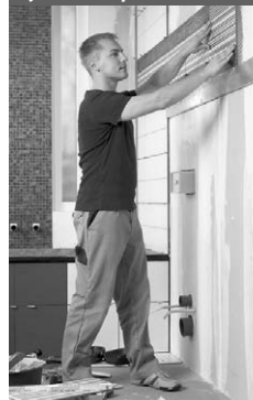
Výstavba a předání
